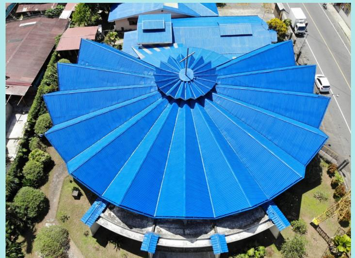
**El techo de la parroquia conduce el agua de lluvia a varios tanques para ser utilizada en los baños del templo.**
